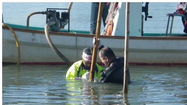
ひび(支柱)を立てています
